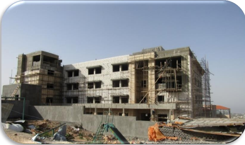
أعمال إنشاء مدرسة مريم بنت عمران الأساسية المختلطة/ محافظة اربد
