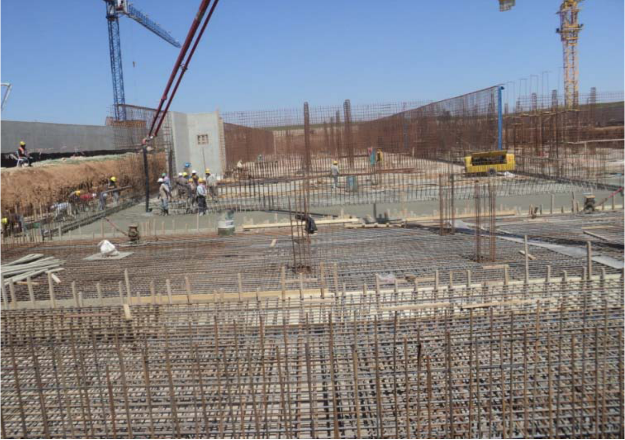
مشروع صرف صحي جنوب عمان
